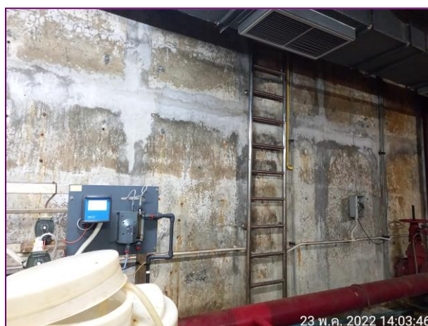
รูปที่ 2.20 ถังสำรองน้ำดับเพลิง
