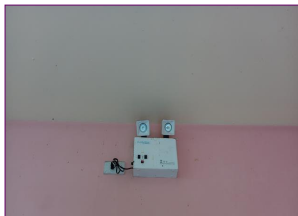
รูปที่ 2.41 ไฟส่องสว่างฉุกเฉิน
