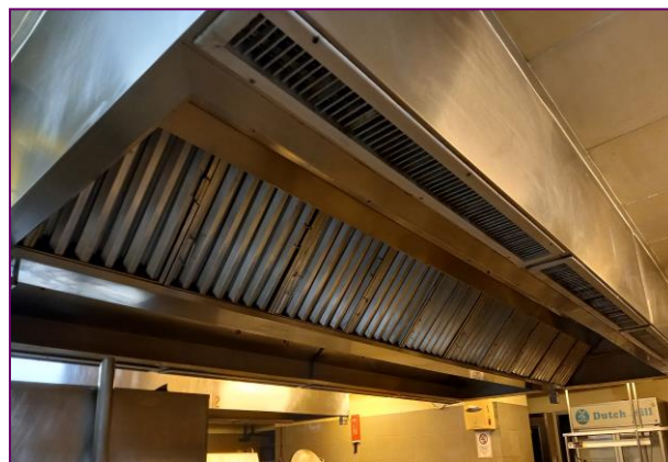
รูปที่ 2.16 ระบบระบายอากาศภายในห้องครัว
